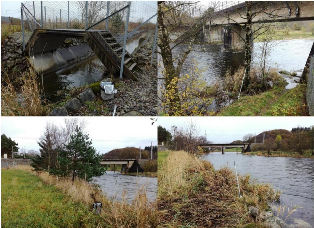
Figur 4-3. Øverst: Nedre del av Skjævelandskanalen (t.v.) og Figgjoelva ved jernbanebro oppstrøms kanalutløp (t.h.). Nederst: I Figgjoelva nedstrøms utløpssona til Skjævelandskanalen finnes det gyteområder for anadrom fisk samt elvemusling.
